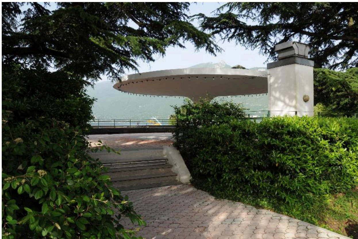
Accès sud au solarium (bât. F)
