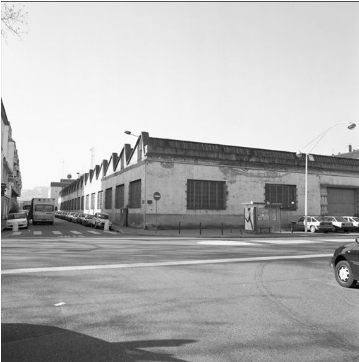
Façade rue Dugas Montbel
