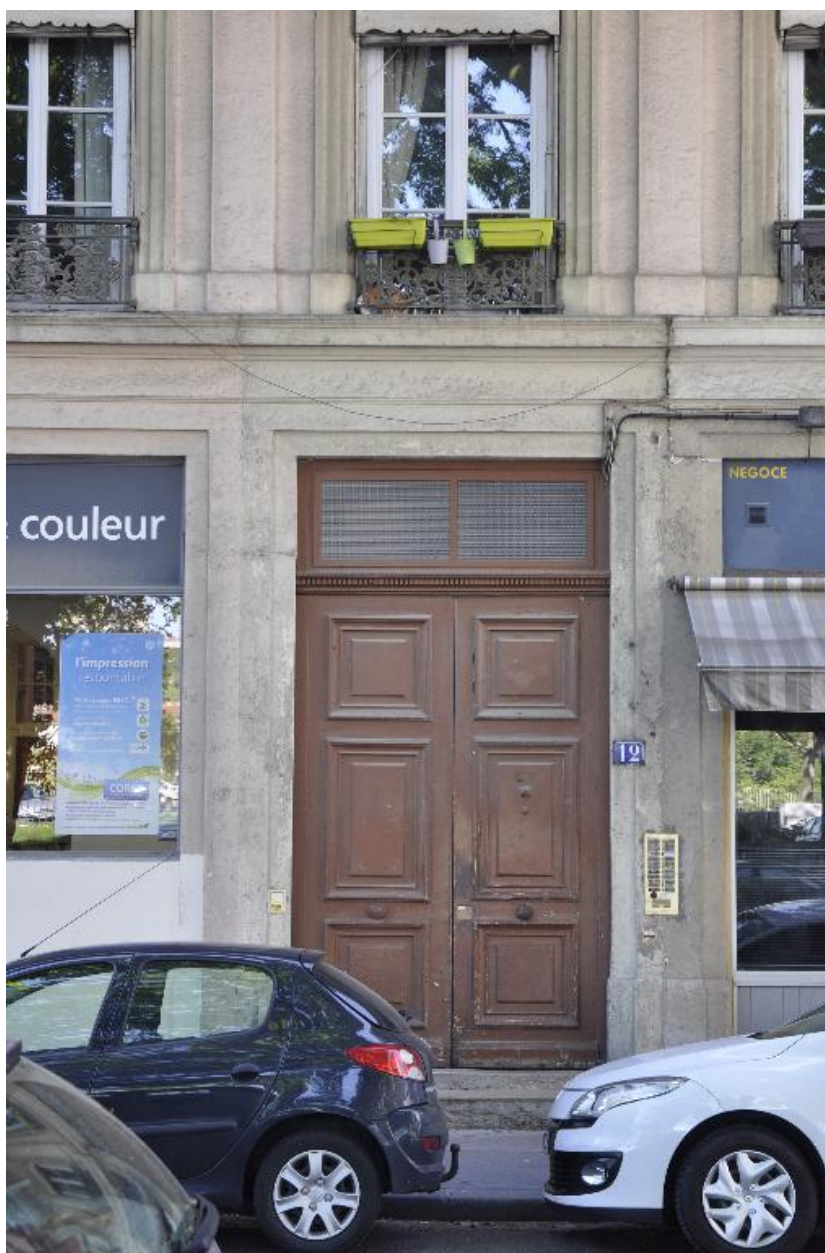
Elévation principale : porte bâtarde, premier étage en entresol
