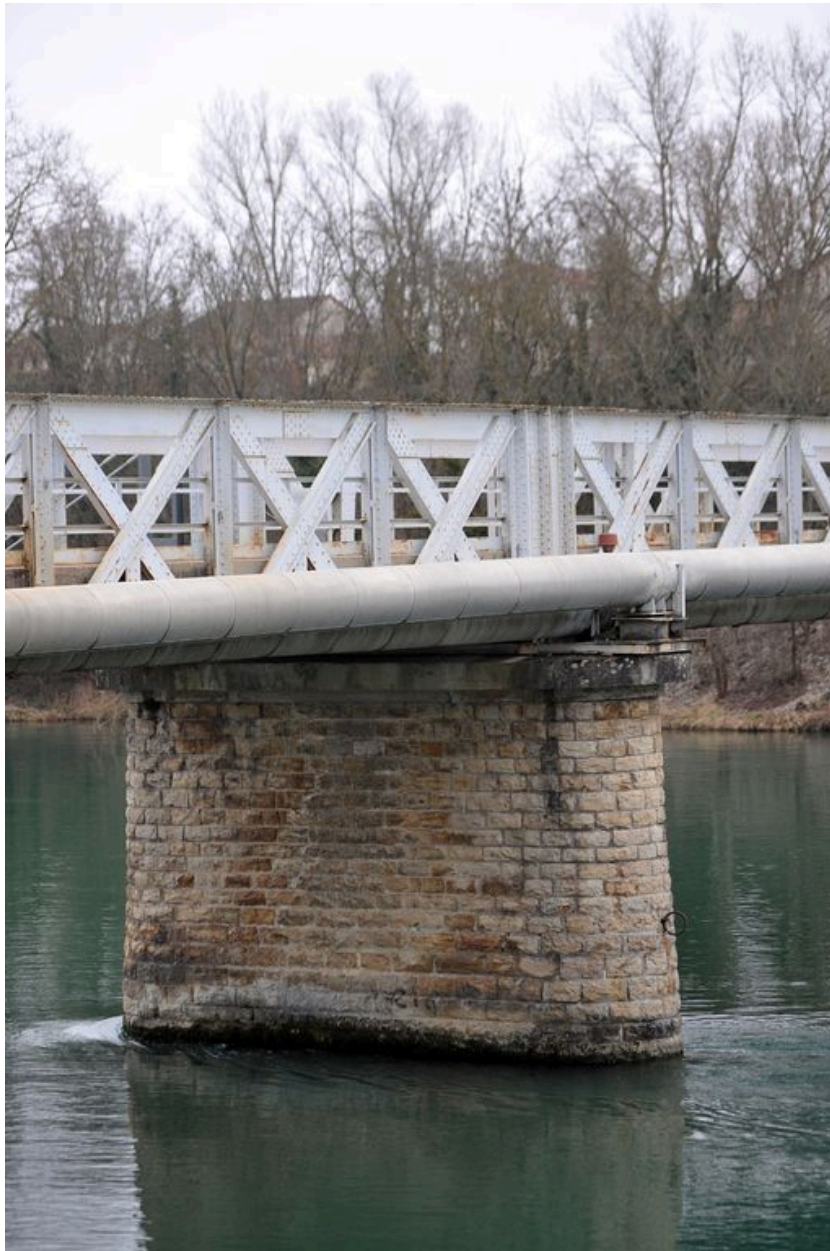
Pile, face aval, vue générale (depuis la rive droite)
