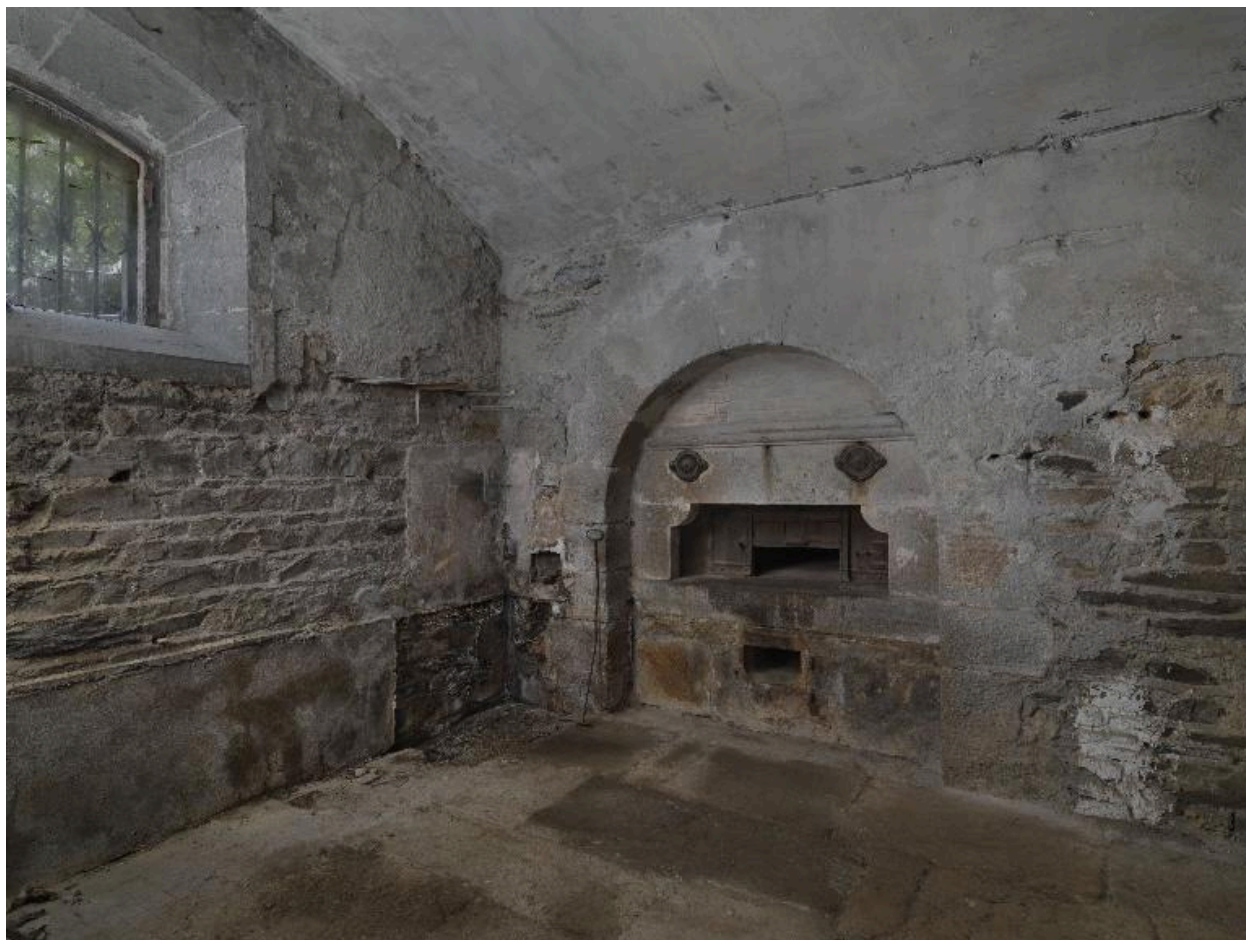
Pavillon sud-ouest, étage de soubassement : ancienne boulangerie, vue d'ensemble depuis l'est
