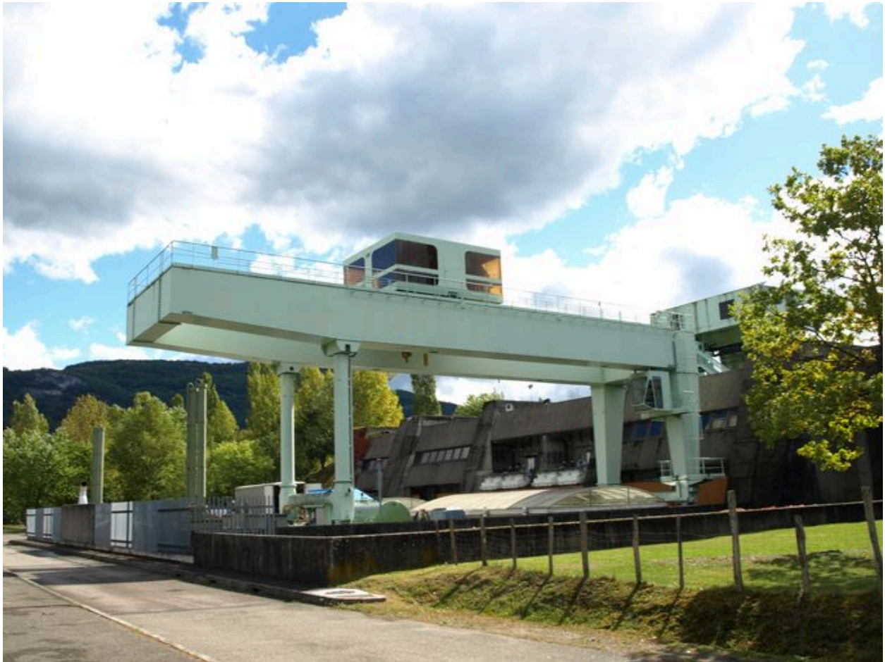
Vue rapprochée, face aval (depuis la rive gauche)
