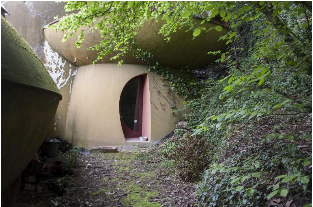
Vue sur le soubassement de la "chambre-noisette" sud greffé sur la tour d'escalier
