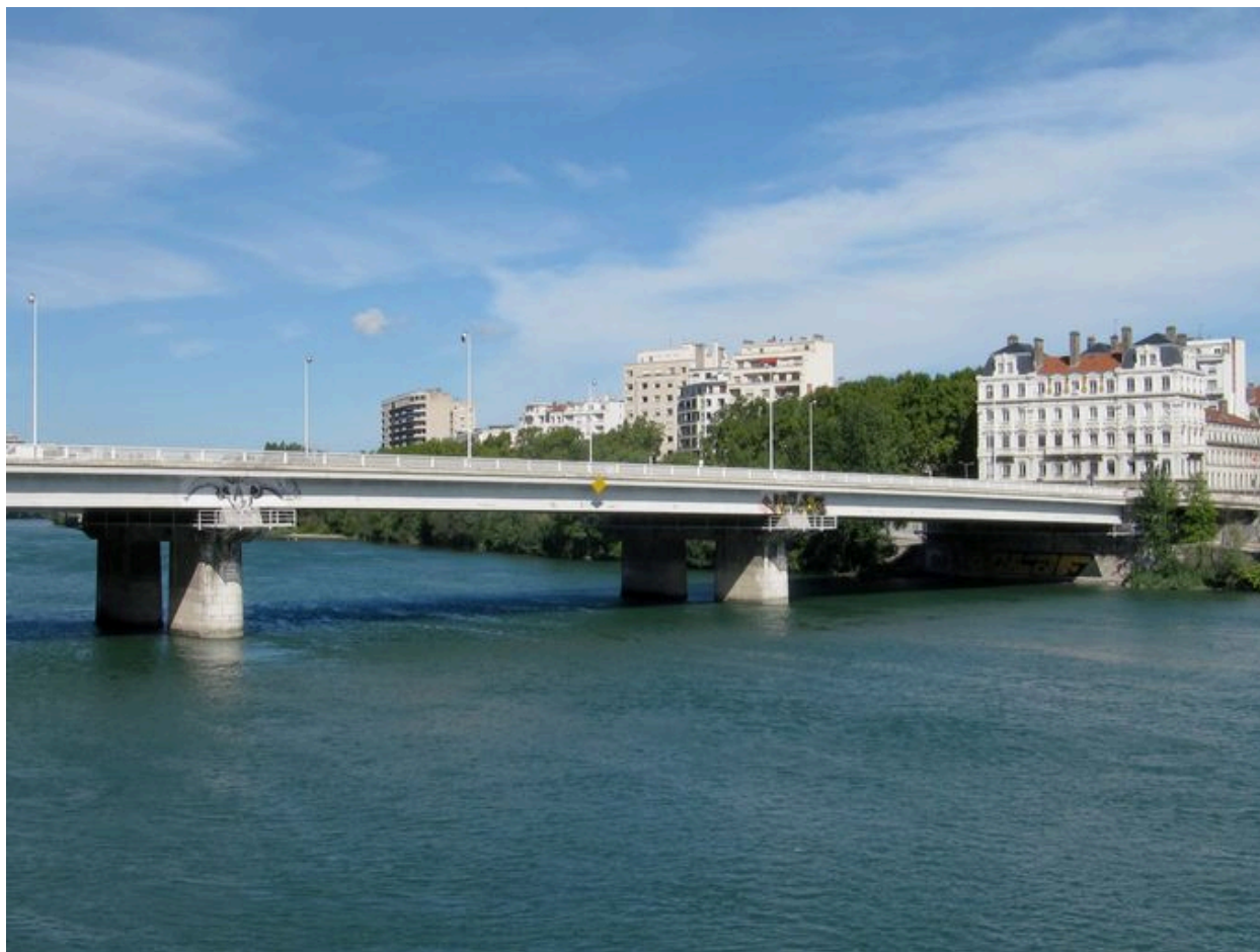
Vue partielle, travées centrale et gauche, face aval (depuis la rive droite)
