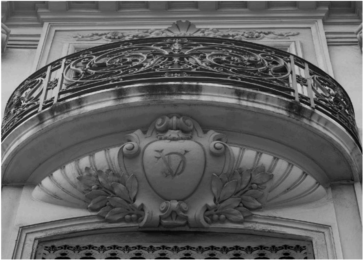
Détail du cul-de-lampe supportant le balcon arrondi, grande rue de la Guillotière
