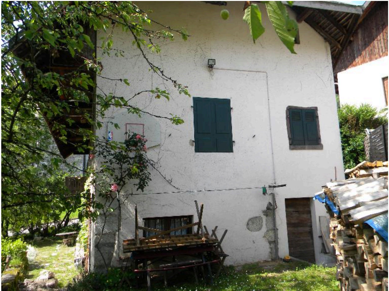
Vue du pignon nord d'une ancienne maison (2008 B2 389, 390).
