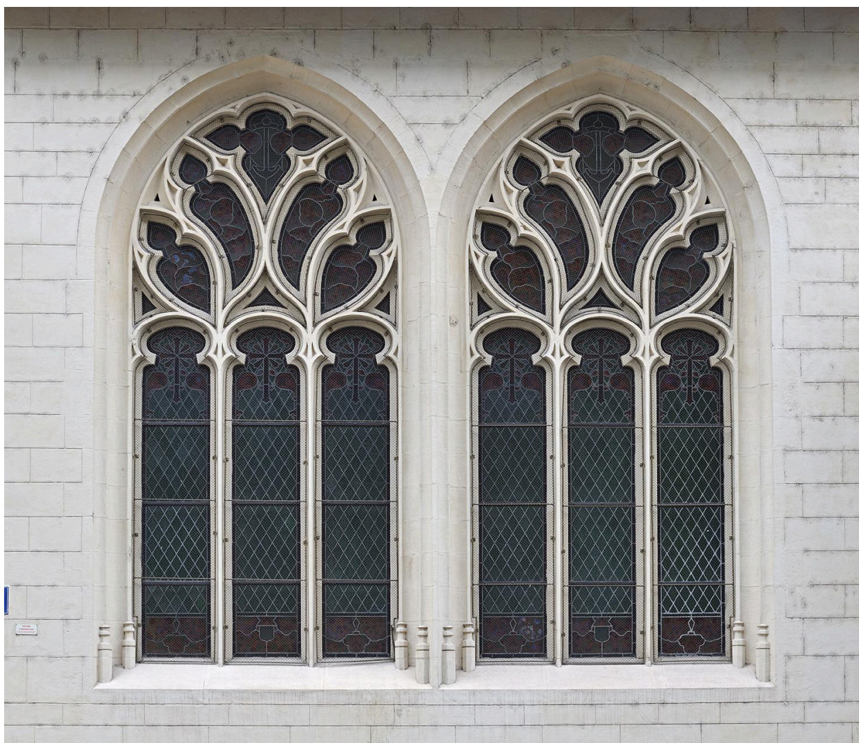
Elévation ouest, baie 1
