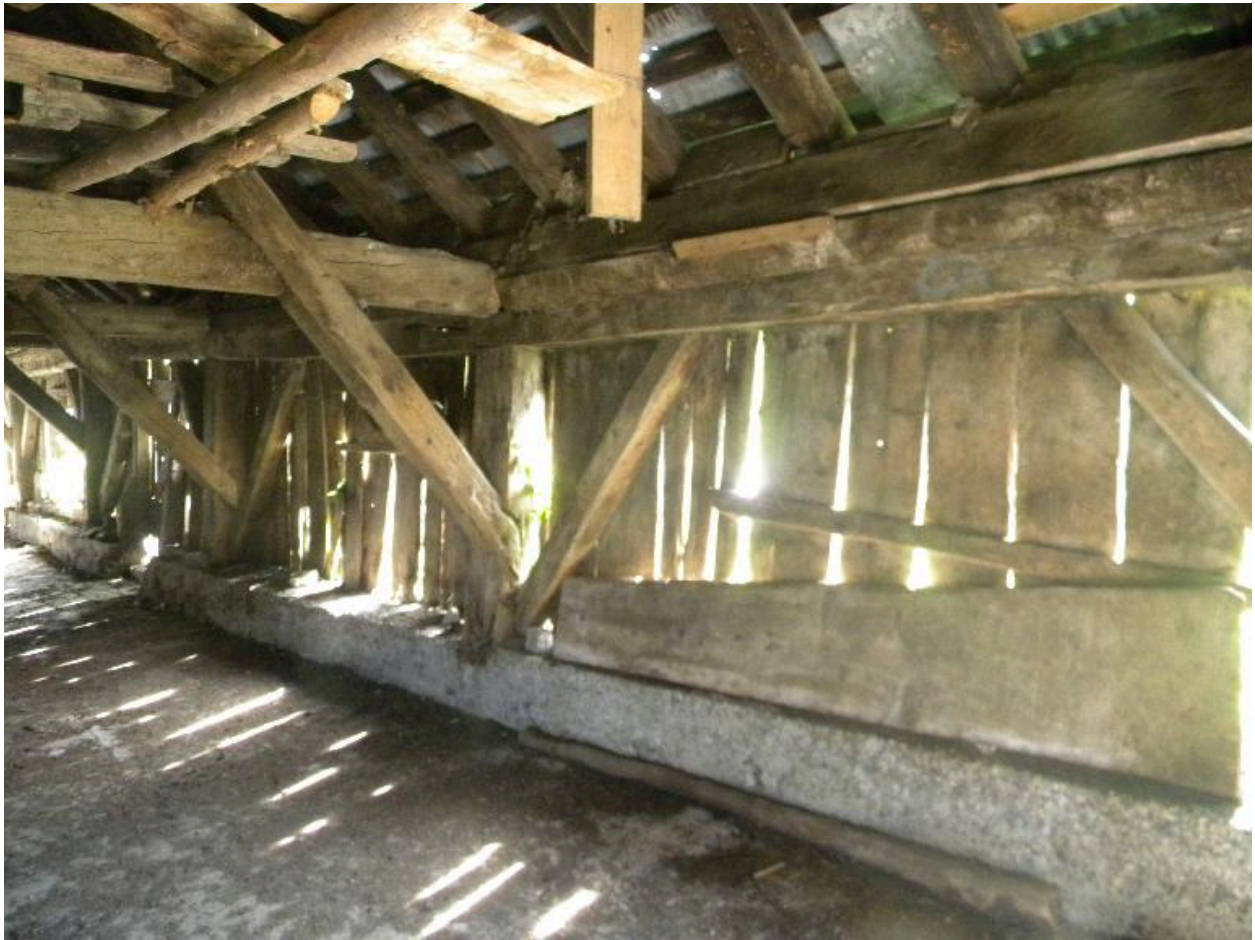
Etable, vue intérieure : mur est, charpente et bardage sur soubassement en béton.
