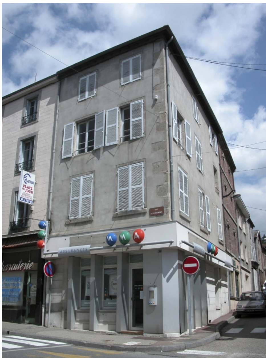
Îlot 2. Clermont (rue de) 67. Vue générale de la façade sur rue.
