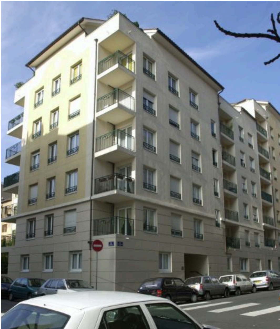
Vue de l'angle des rues Marc-Antoine-Petit et Quivogne depuis le nord-ouest
