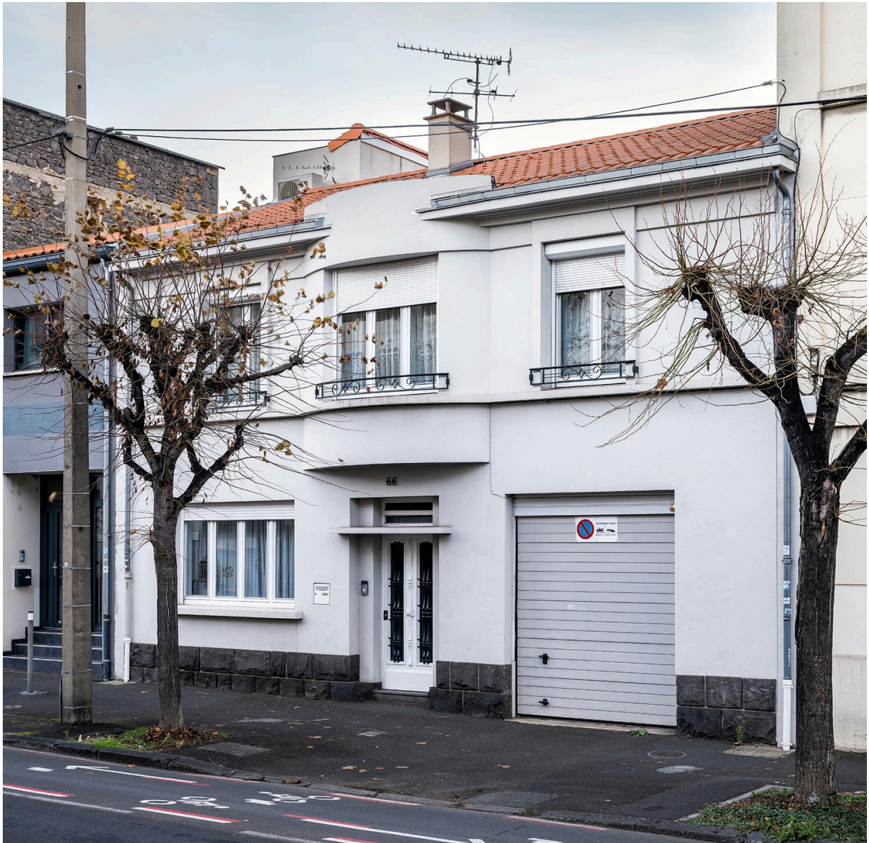
Façade sur le boulevard Jean-Jaurès
