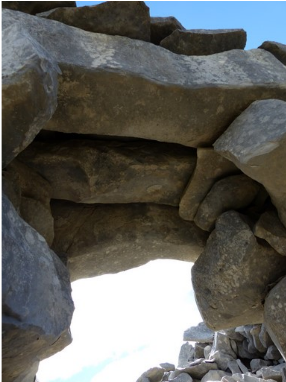
Linteaux de la porte d'une cabane, quartier de Banastier.
