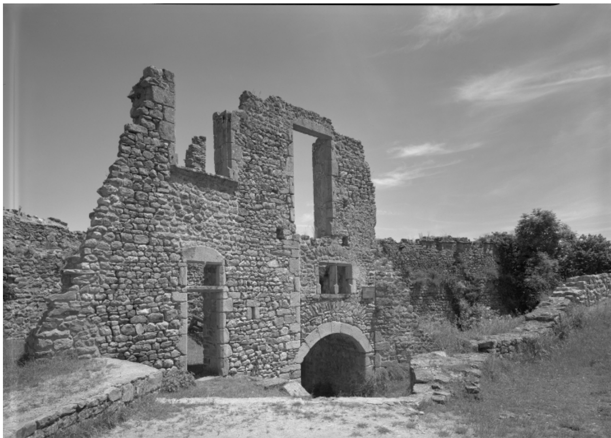
Premier baile, partie nord-est : vue du premier ouvrage d'entrée, du nord.
