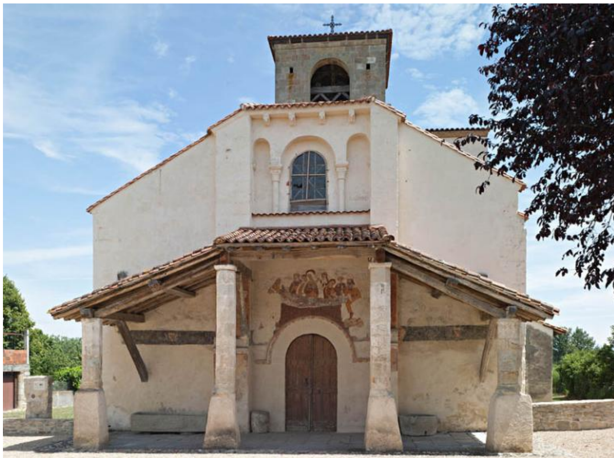
Vue générale de la façade occidentale.
