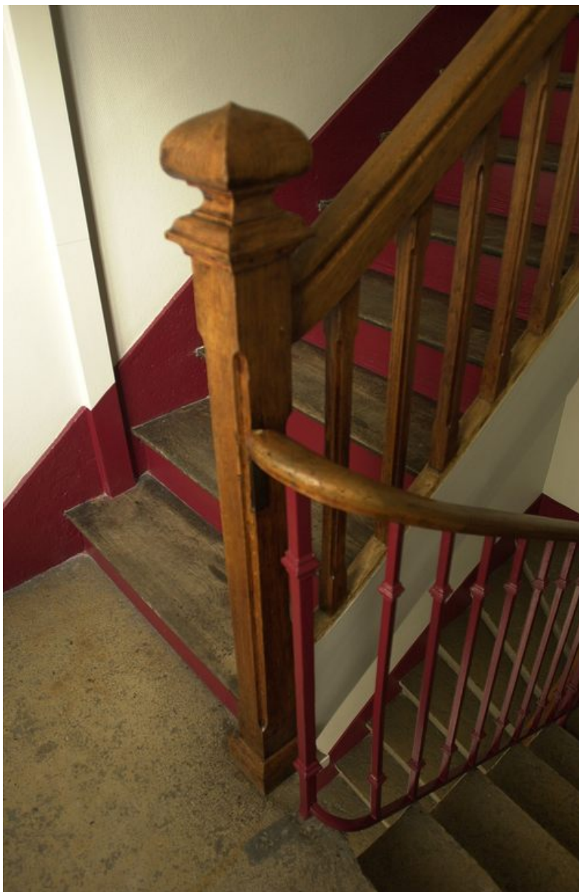
Escalier : garde-corps en fonte et garde-corps en bois
