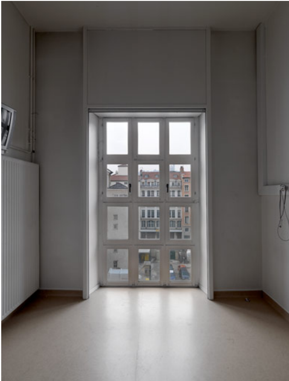
Bâtiment B. 1er étage. Fenêtre côté cour
