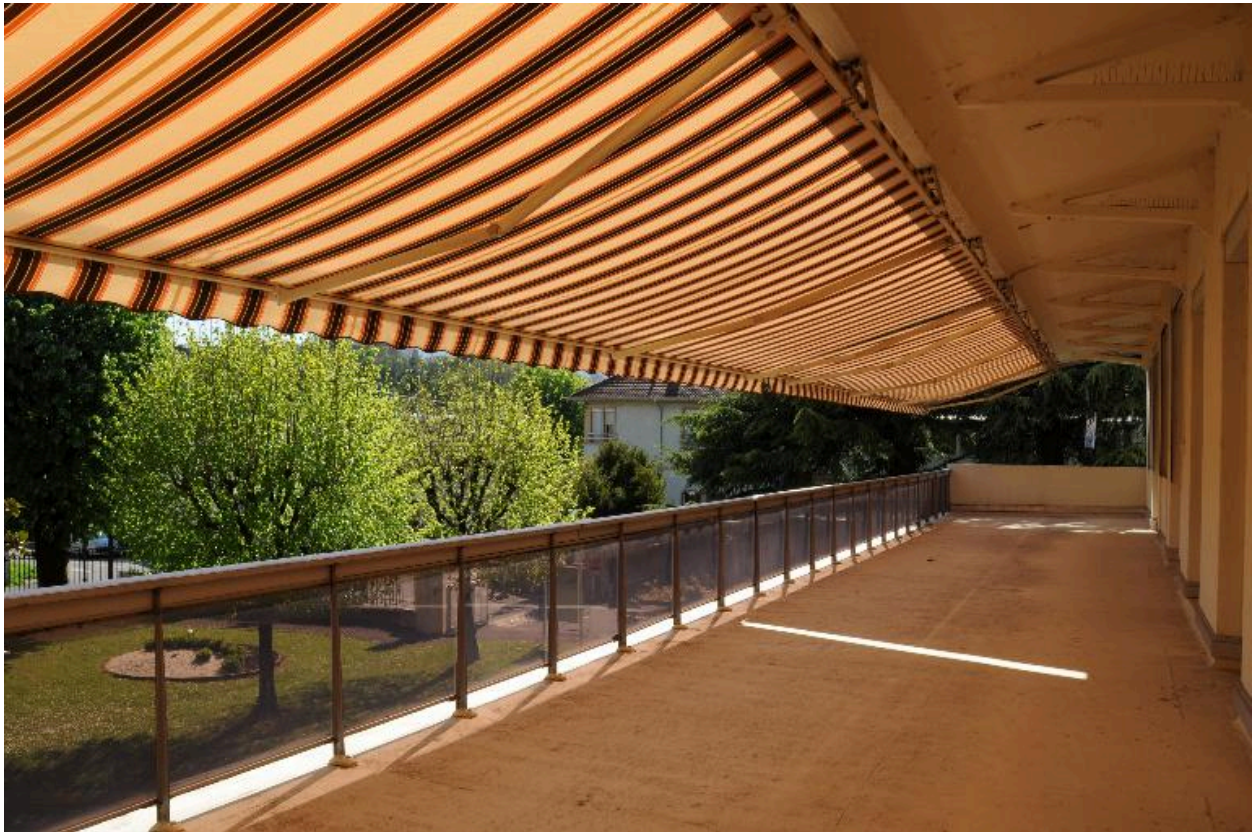
Terrasse du 1er étage, aile gauche
