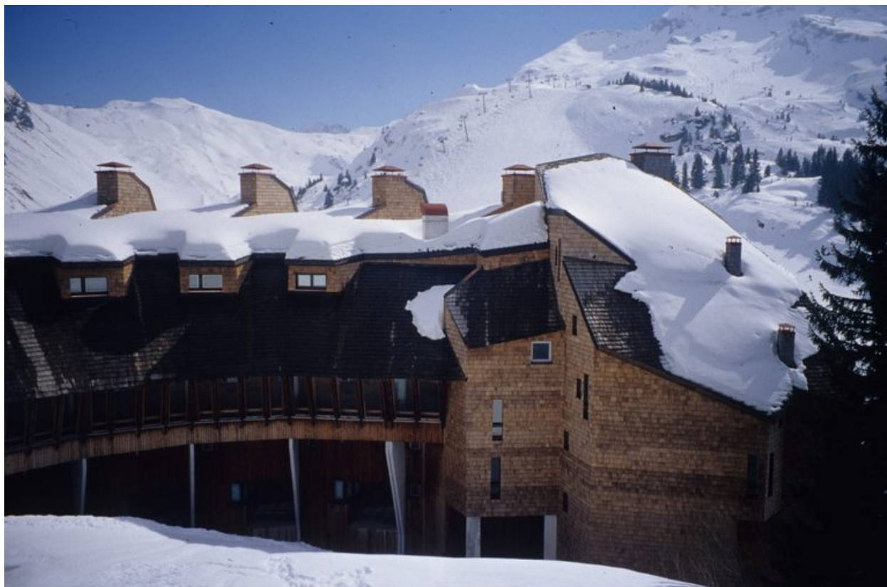
La façade nord avec la coursive publique en encorbellement
