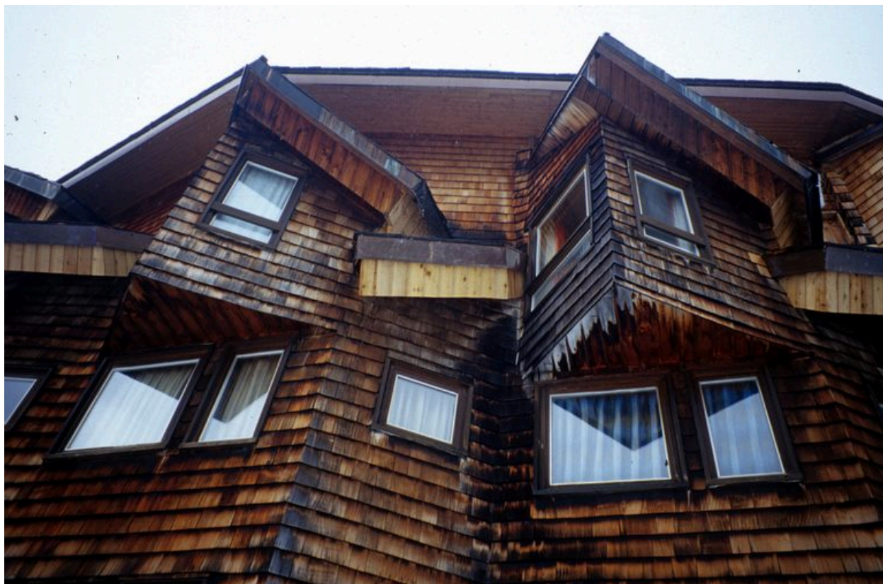
Détail de la façade nord
