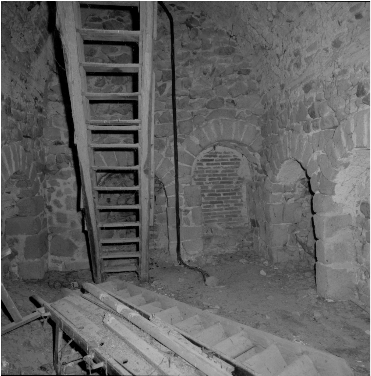
Vue intérieure de la salle haute du clocher : angle ouest.
