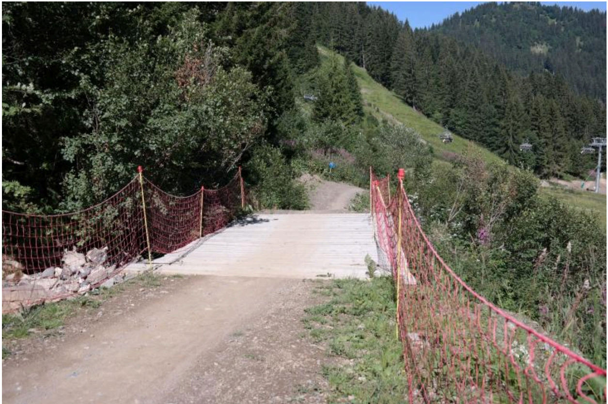
Passerelle VTT de Plaine-Dranse, vue du tablier
