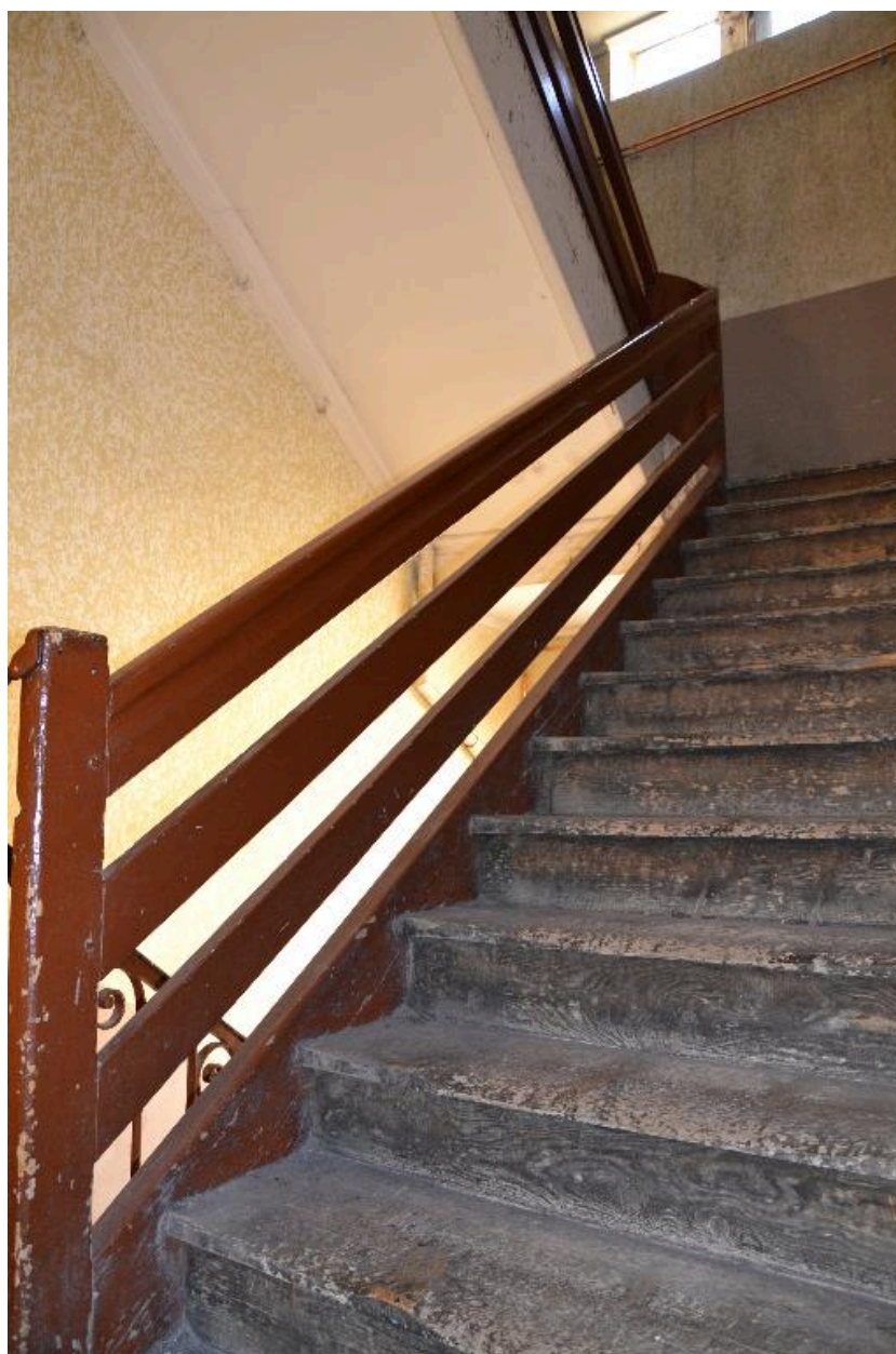
Escalier dernier niveau
