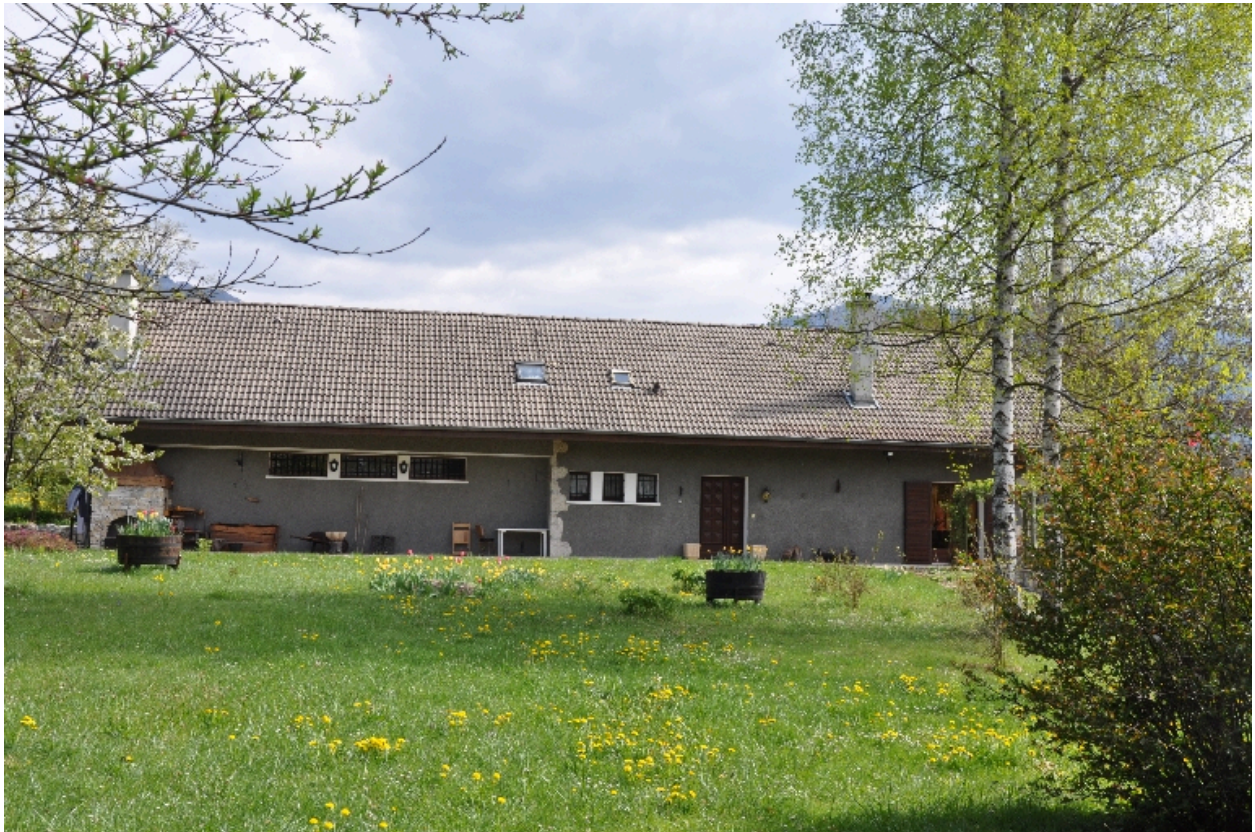
Vue générale du bâtiment reconverti de l'ancienne scierie
