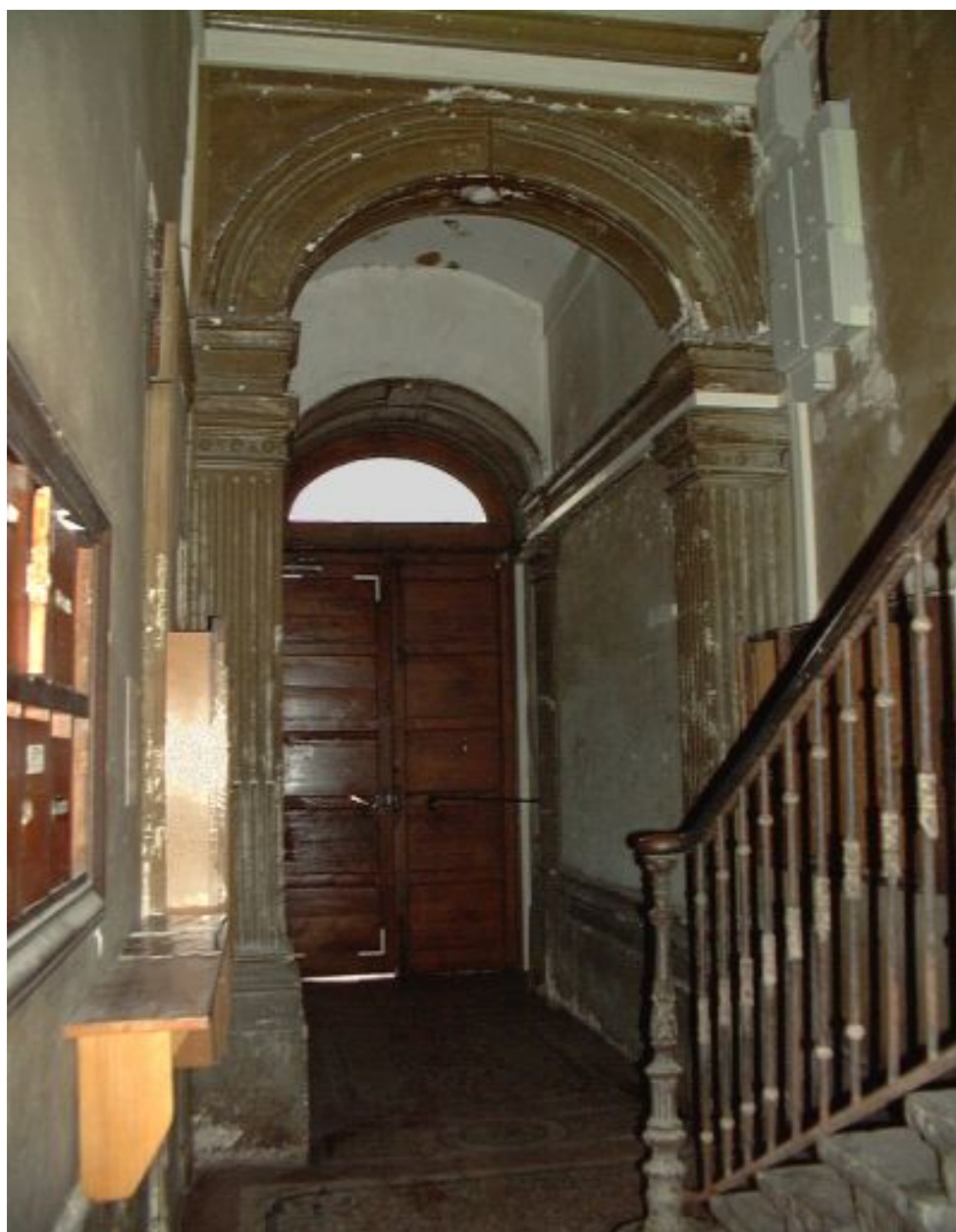
Le vestibule depuis le fond
