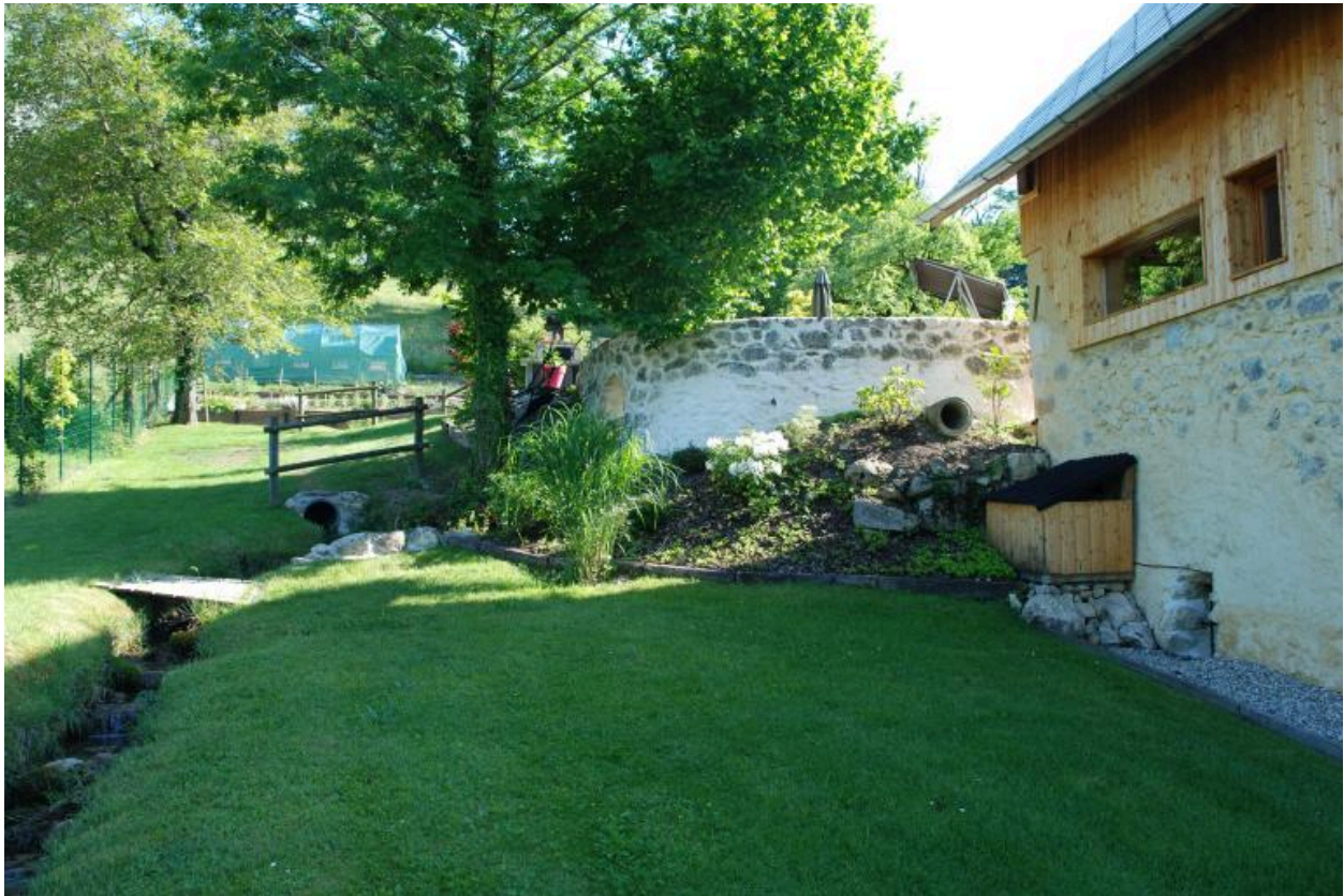
Vue d'ensemble du bâtiment avec, en second plan la retenue d'eau qui actionnait la roue placée sur la façade ouest de l'édifice.
