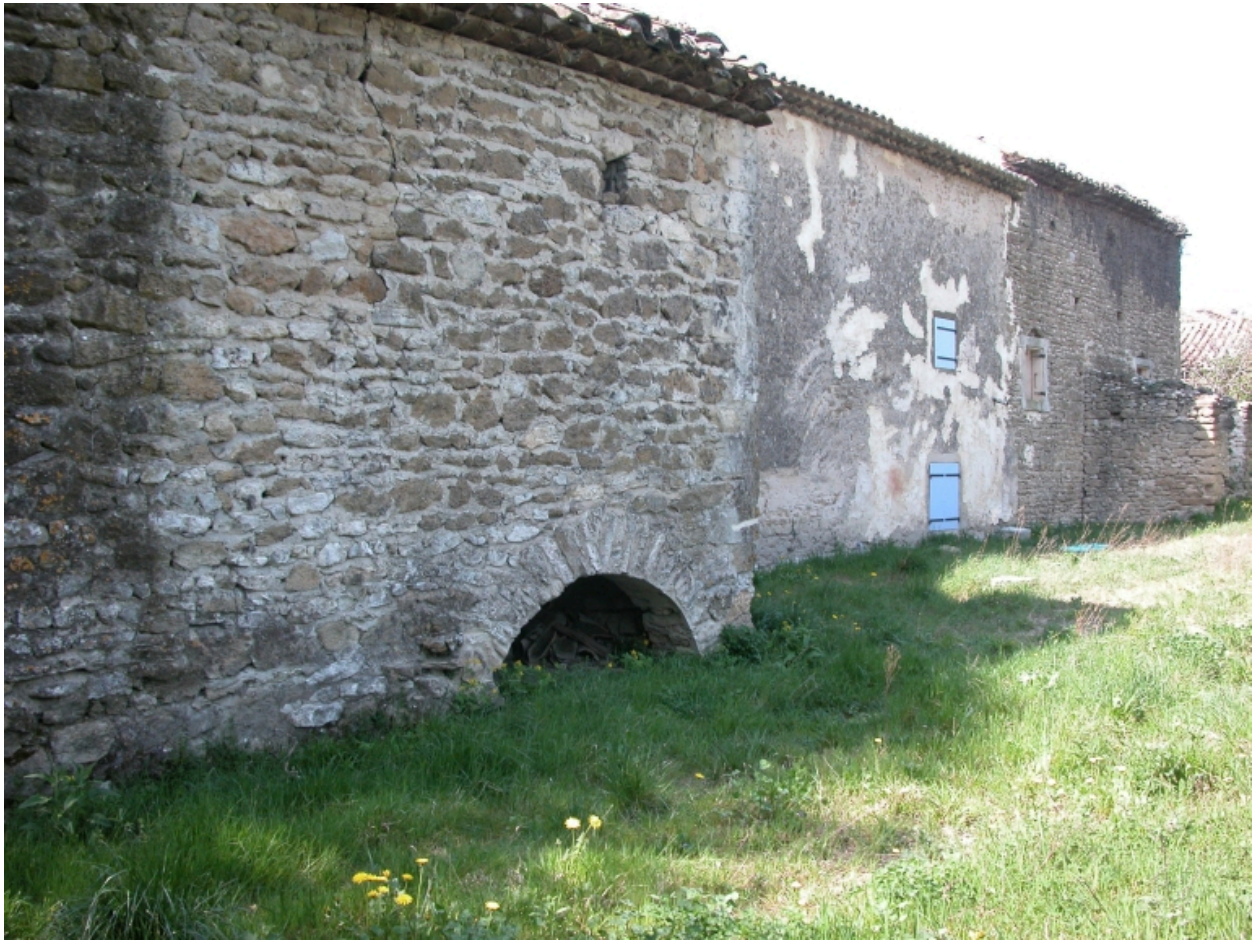
Les Vernets, vue générale nord-est du moulin et du bief
