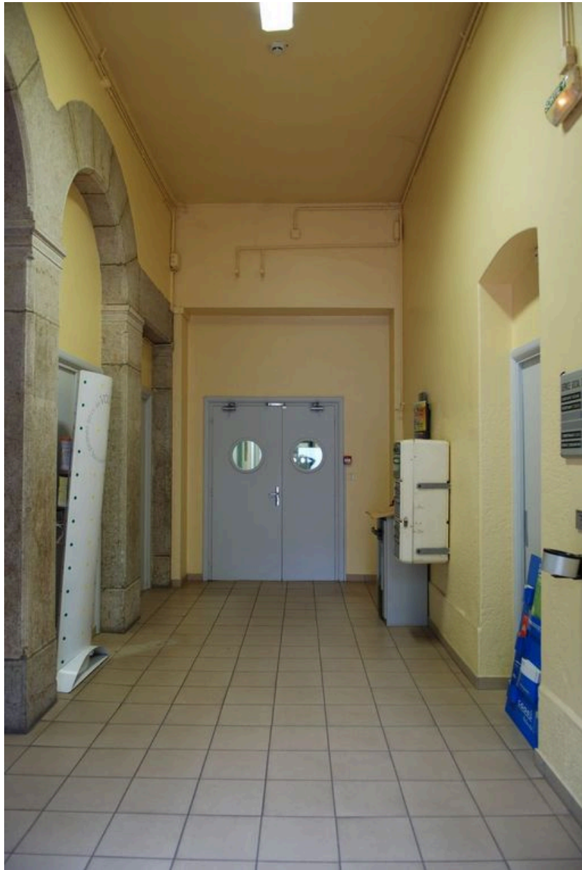
Couloir nord-sud, rez-de-chaussée du bâtiment des services généraux
