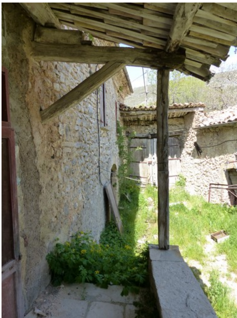
Ensemble occidental. Élévation est, palier filant couvert.
