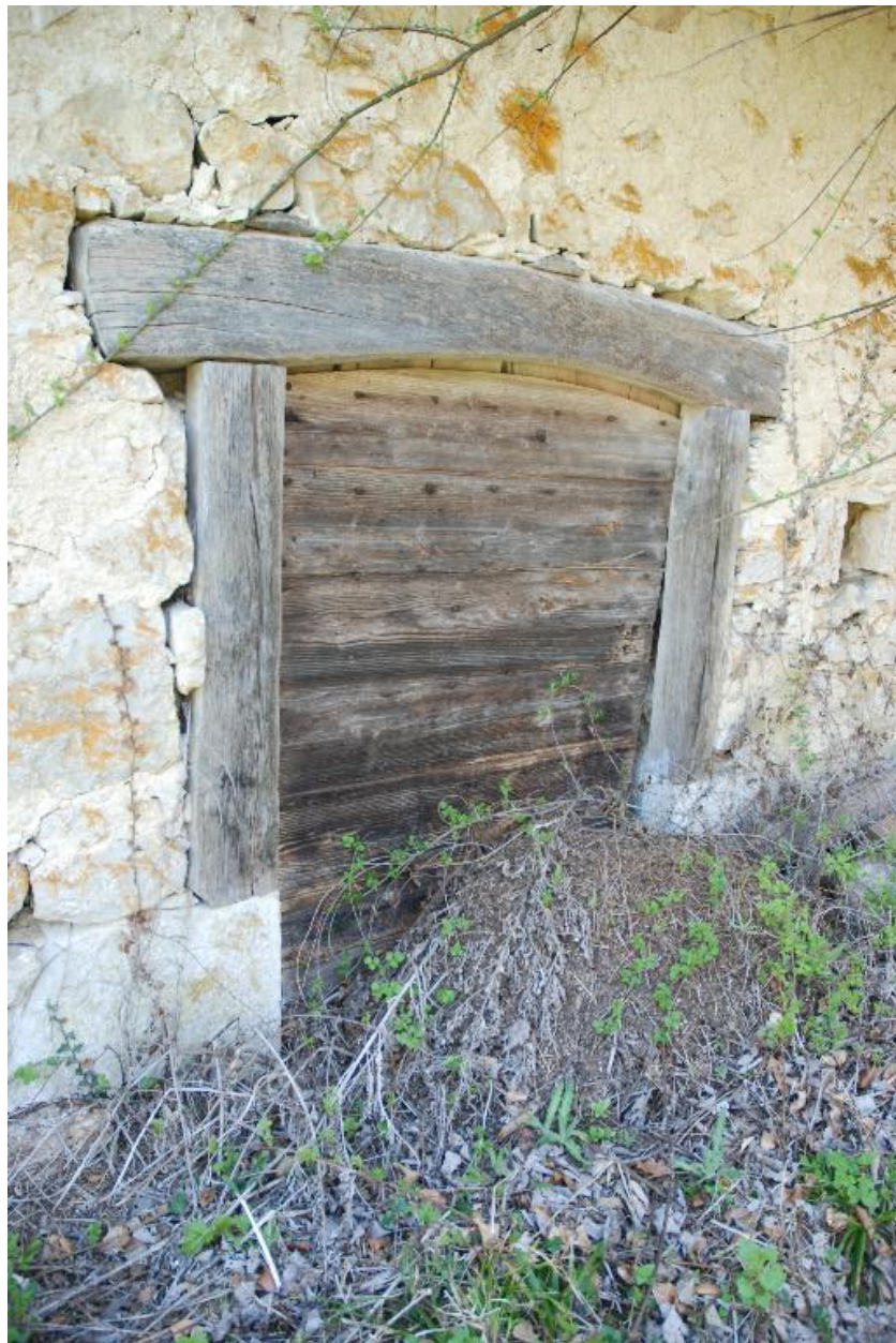
Vue d'ensemble de la porte d'accès à l'étable.
