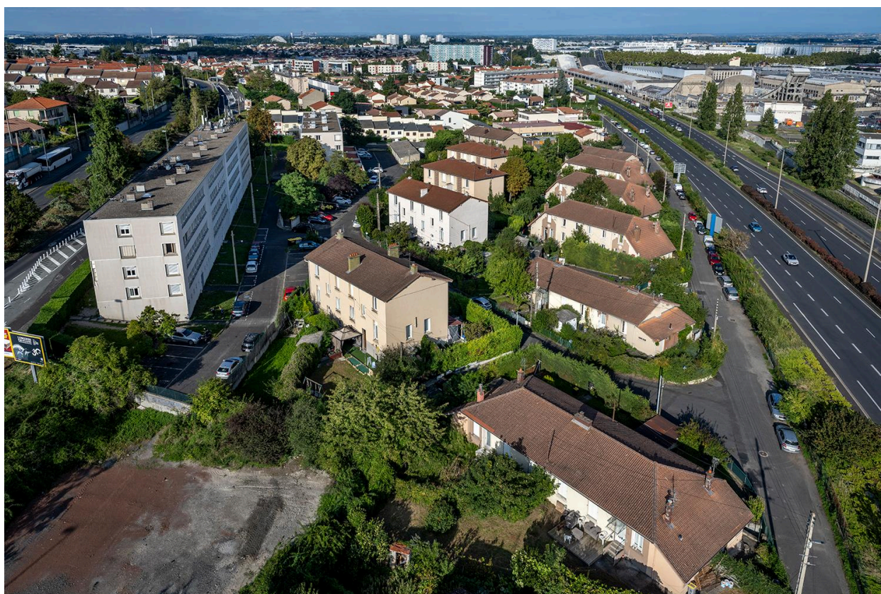
Vue aérienne de la cité depuis le sud-ouest.
