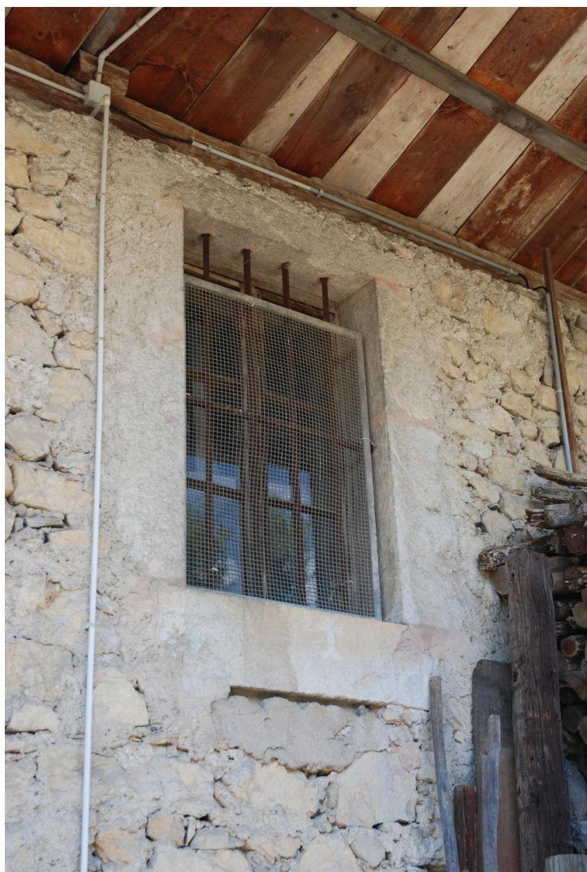
Fenêtre de l'habitation nord (2018 YC 127).
