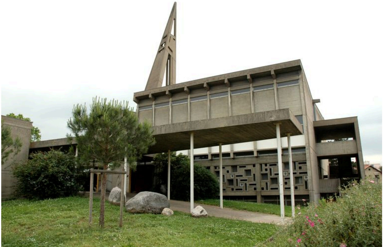
Le clocher, le corps de bâtiment nord et l'escalier construit contre la façade latérale nord
