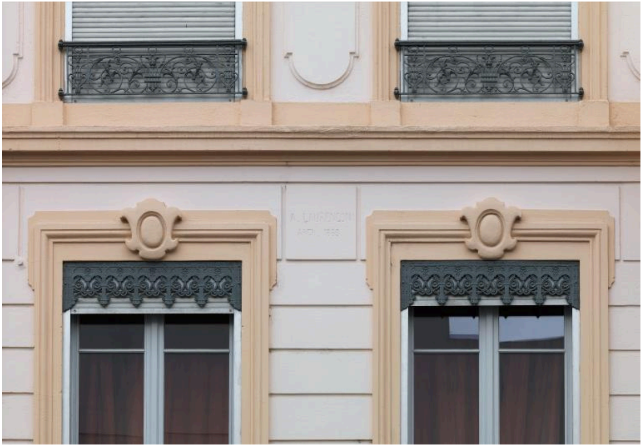
Élévation sur rue, détail du premier étage : signature de l'architecte et date portée
