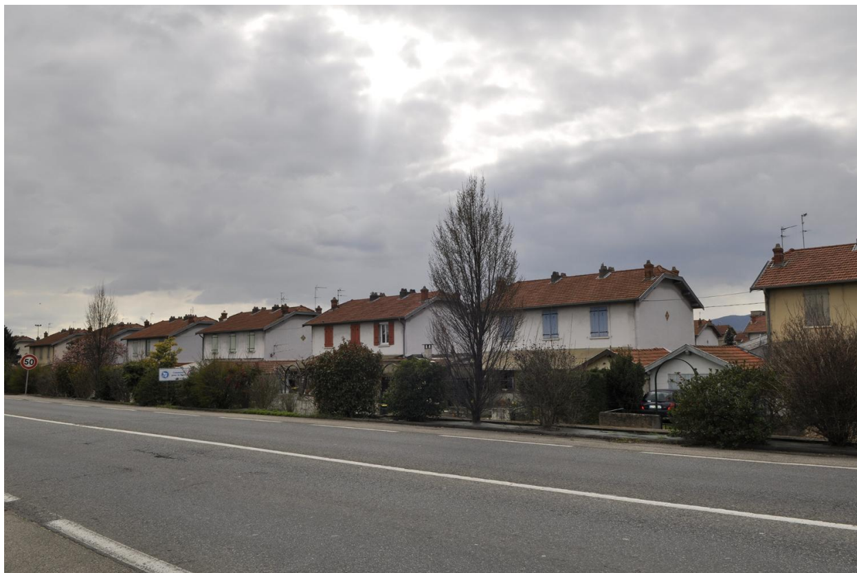
Vue d'un ensemble de maisons ouvrières depuis la route nationale 7.
