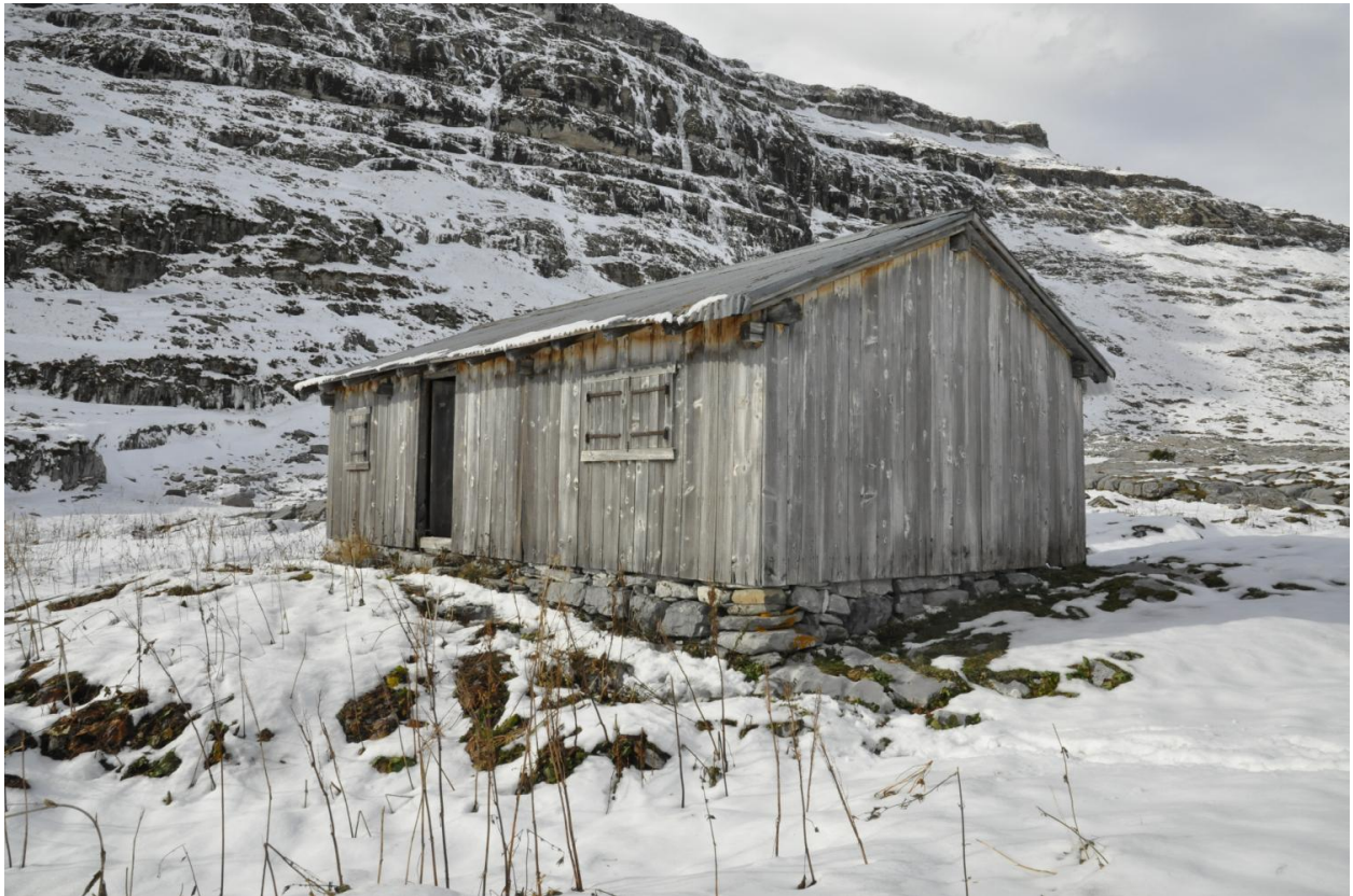
Vue de l'élévation sud est à la fin de l'hiver
