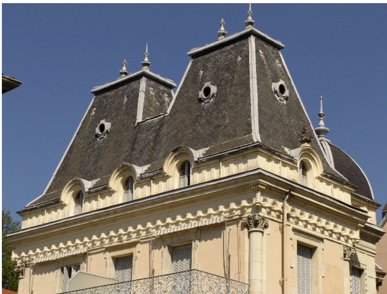
Vue des toits
