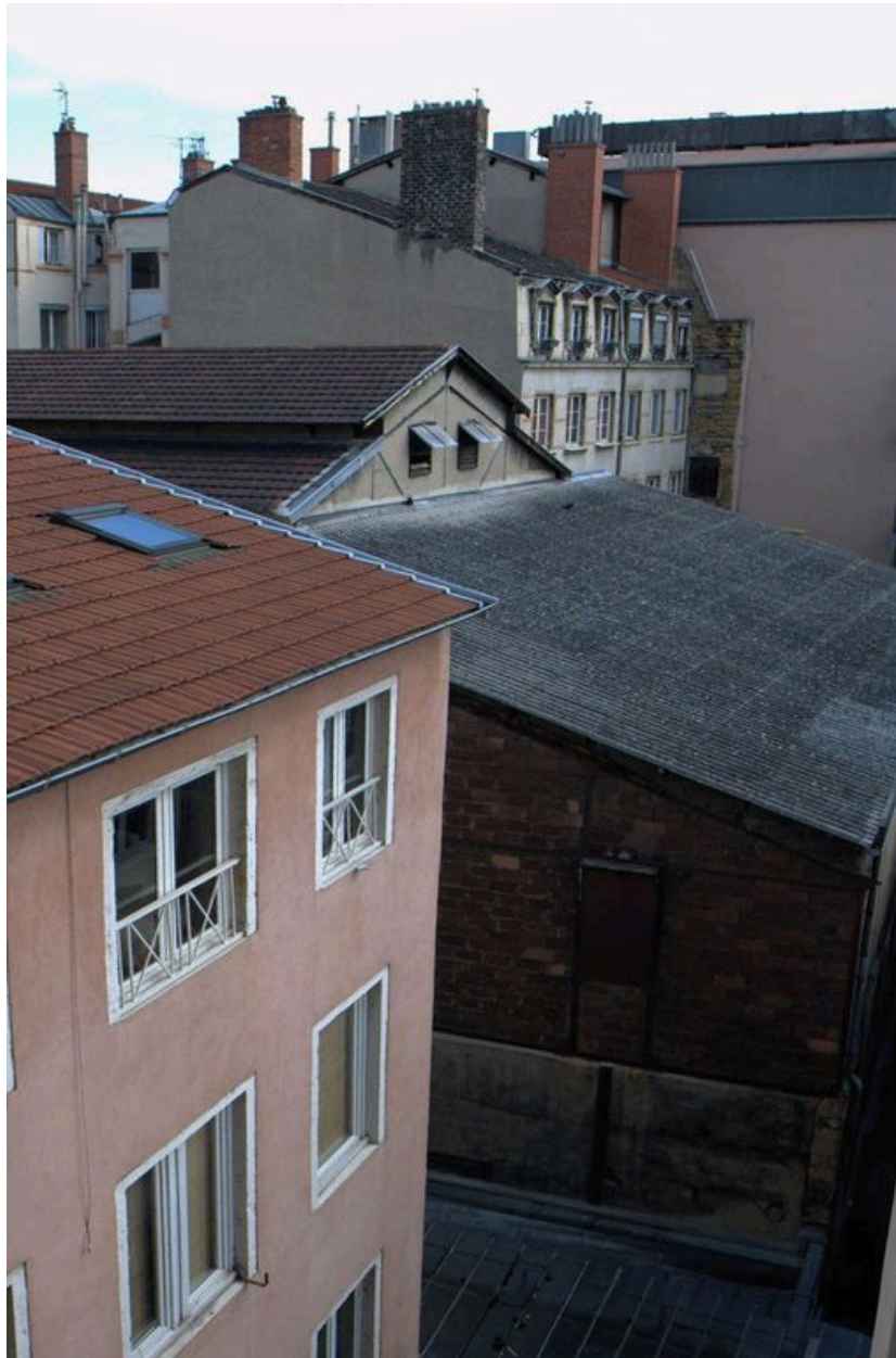
Vue partielle de l'élévation postérieure, depuis le sud-ouest
