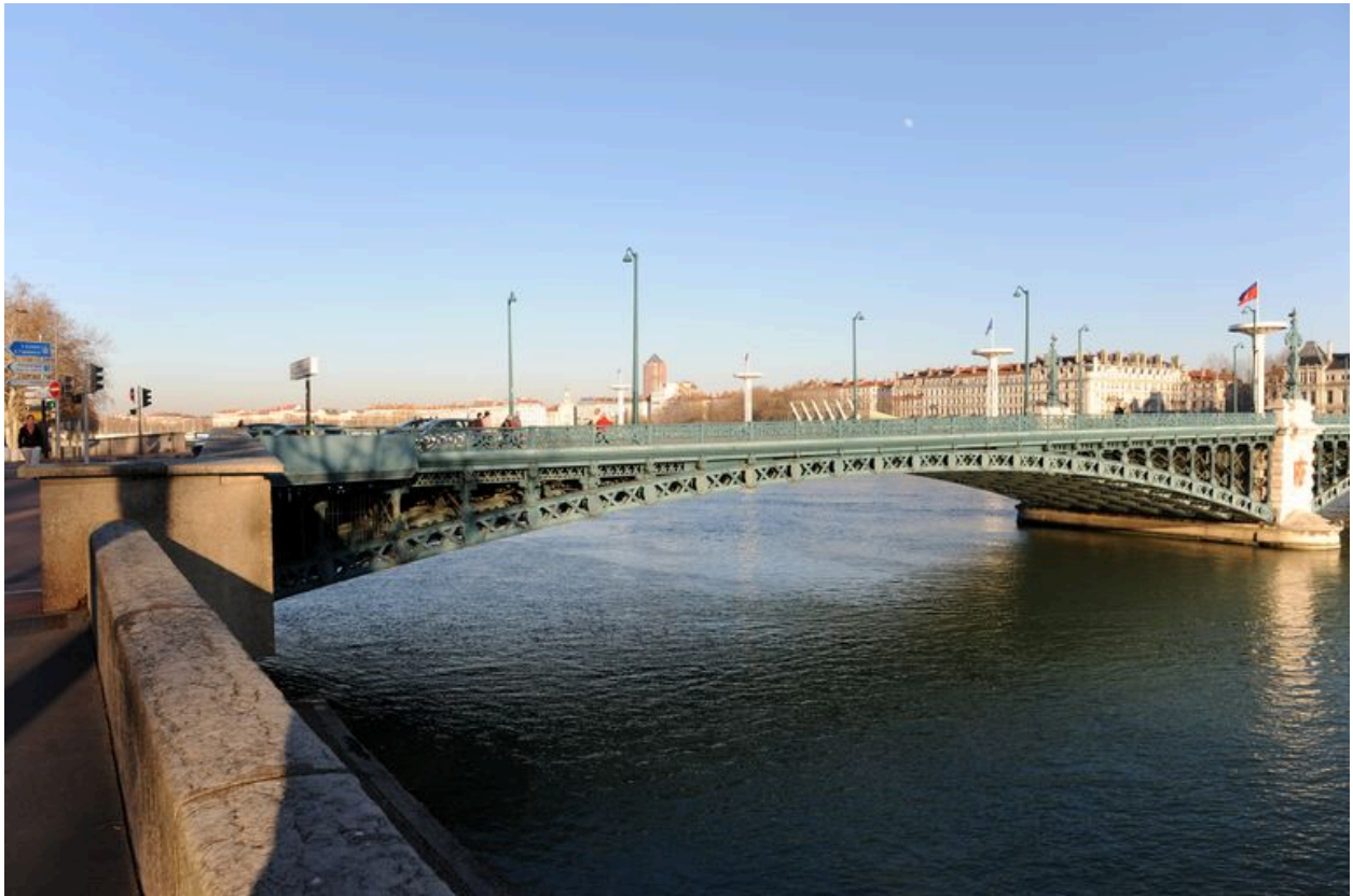
Vue partielle, travée droite, face aval (depuis la rive droite)
