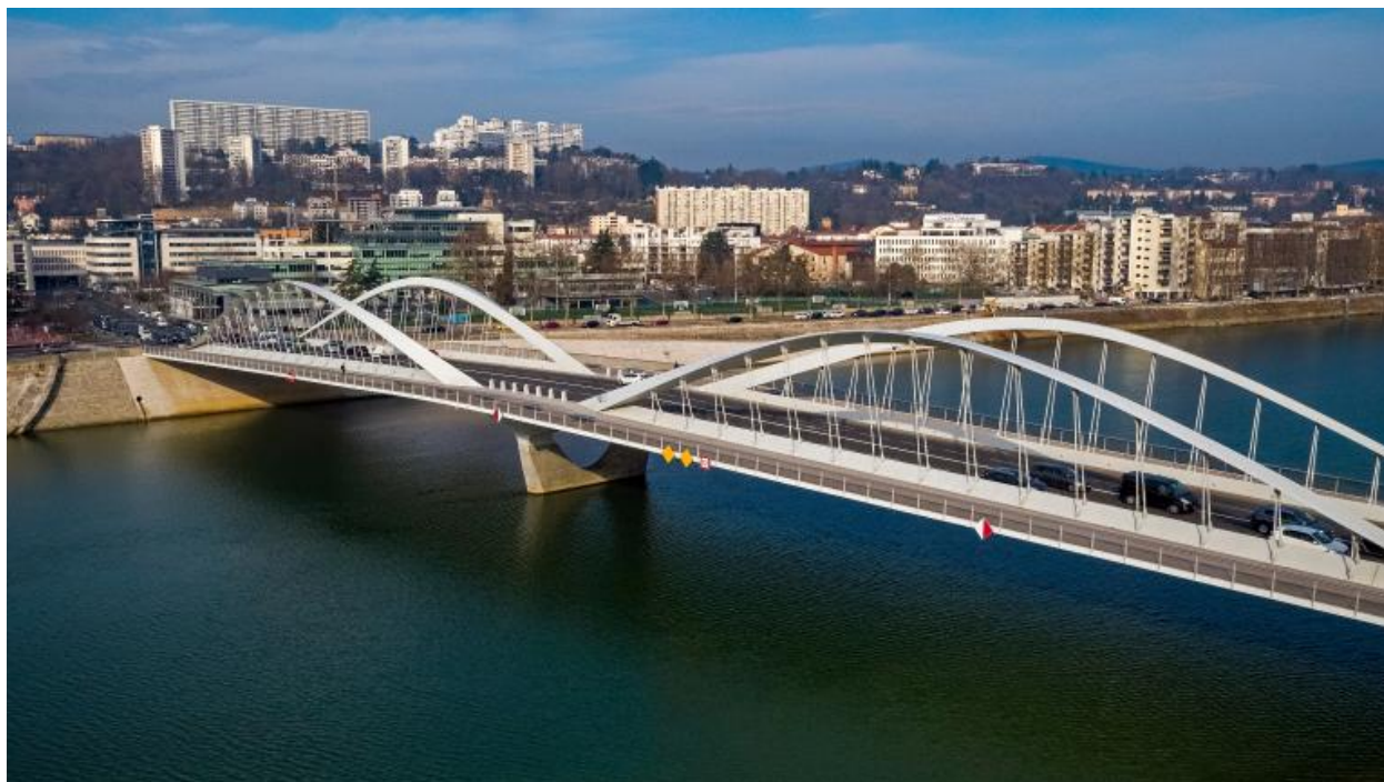
Vue d'ensemble sud-est du pont Schuman (drône)
