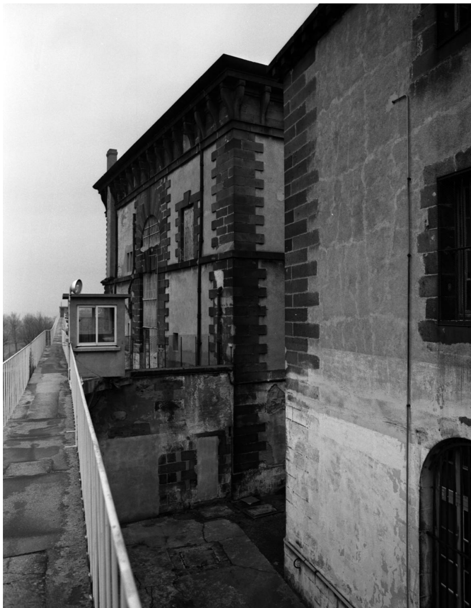
Depuis le chemin de ronde nord, élévation latérale nord du bâtiment G (de l'administration).
