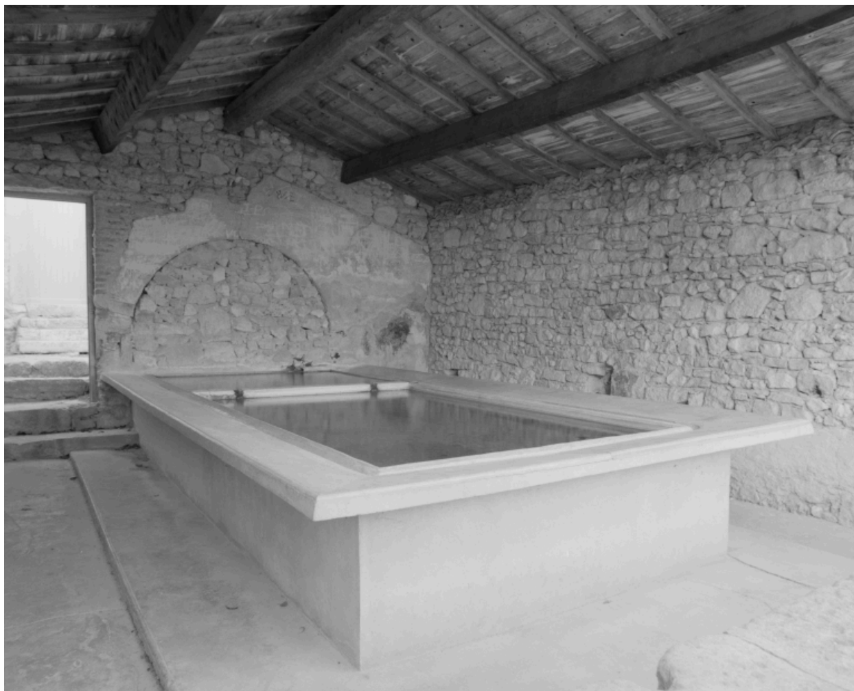
Montjoyer. Village. Vue générale du lavoir.
