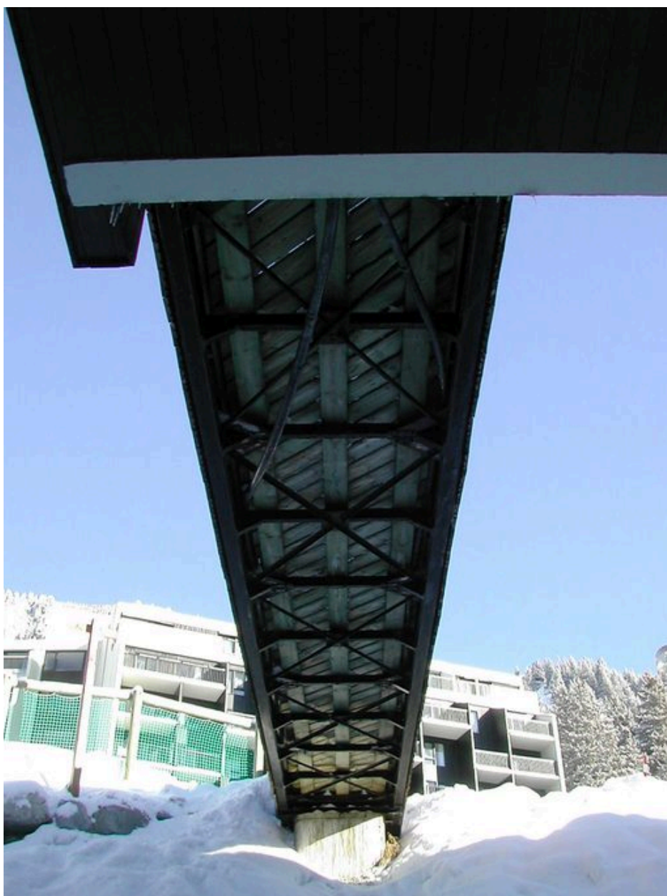
Détail de la passerelle d'accès
