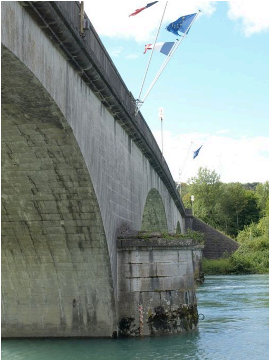
Vue partielle, de côté, piles et culée gauche, face aval (depuis la rive droite)
