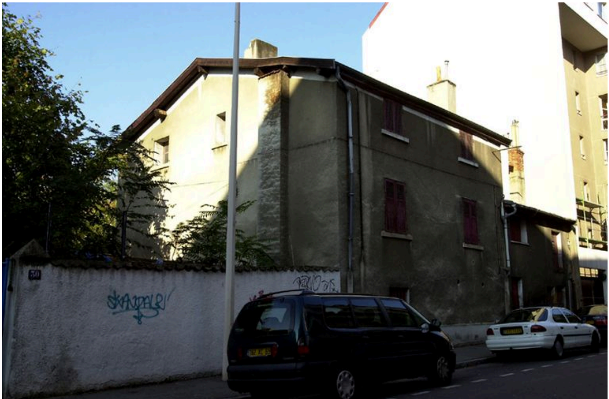
Élévation sur rue depuis le sud-est
