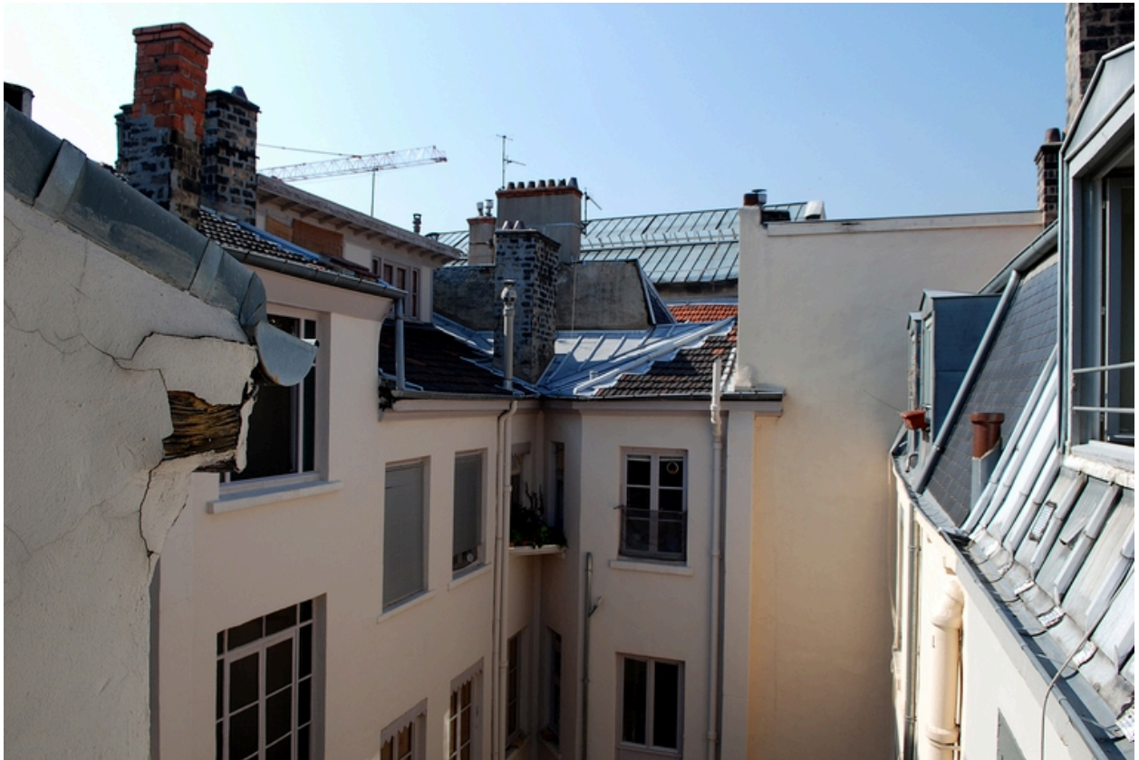
Vue de situation de la verrière depuis l'escalier de l'immeuble sis 15 rue Gasparin
