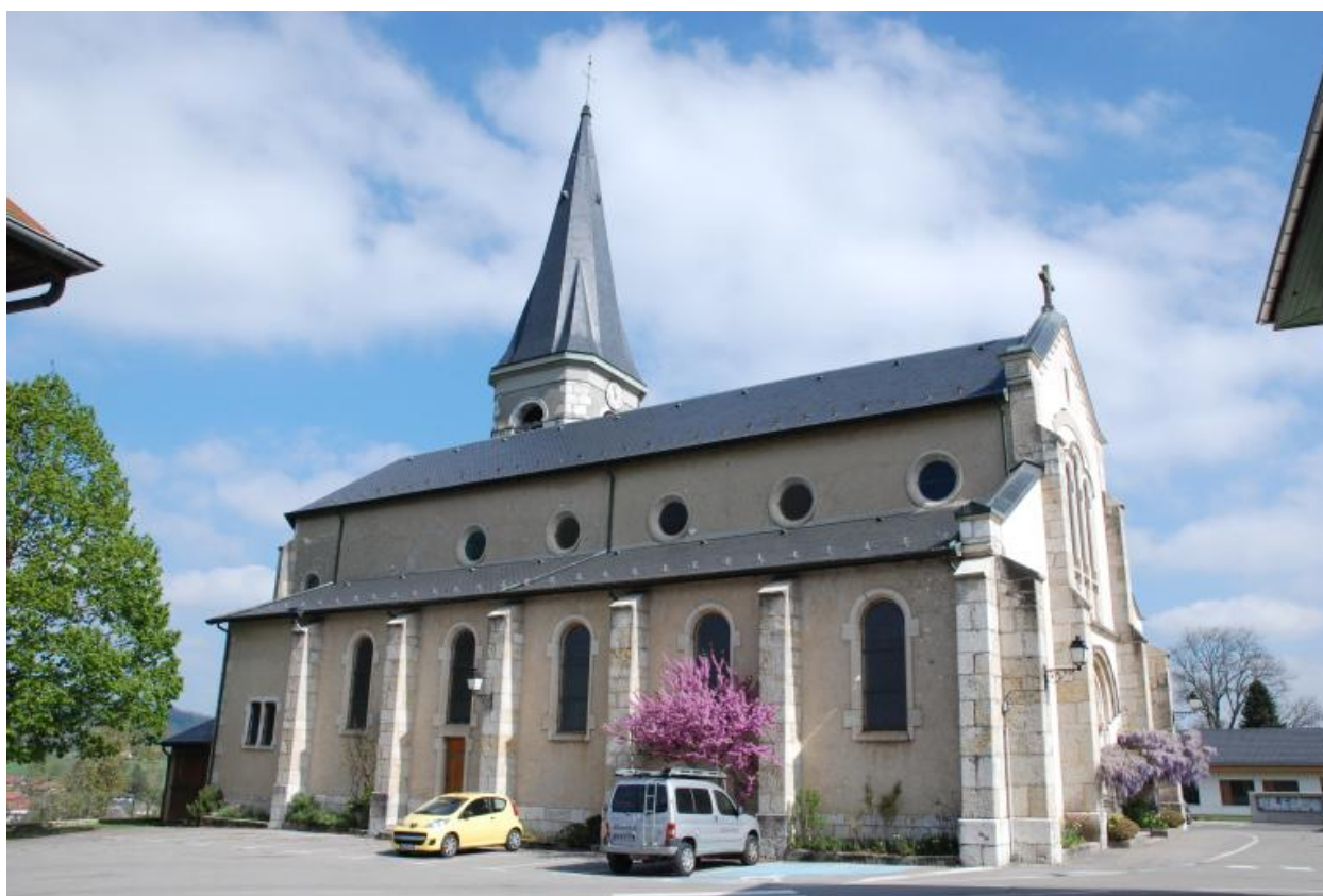
Vu d'ensemble de trois-quarts de l'église depuis le sud-est.
